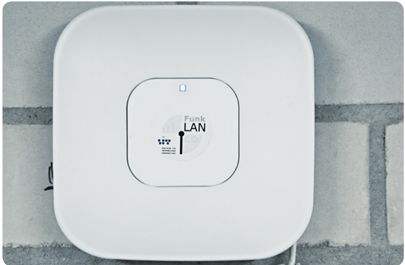
WLAN-Access-Points wie dieser versorgen die Uni mit schnellem Internet nach n-Standard.
