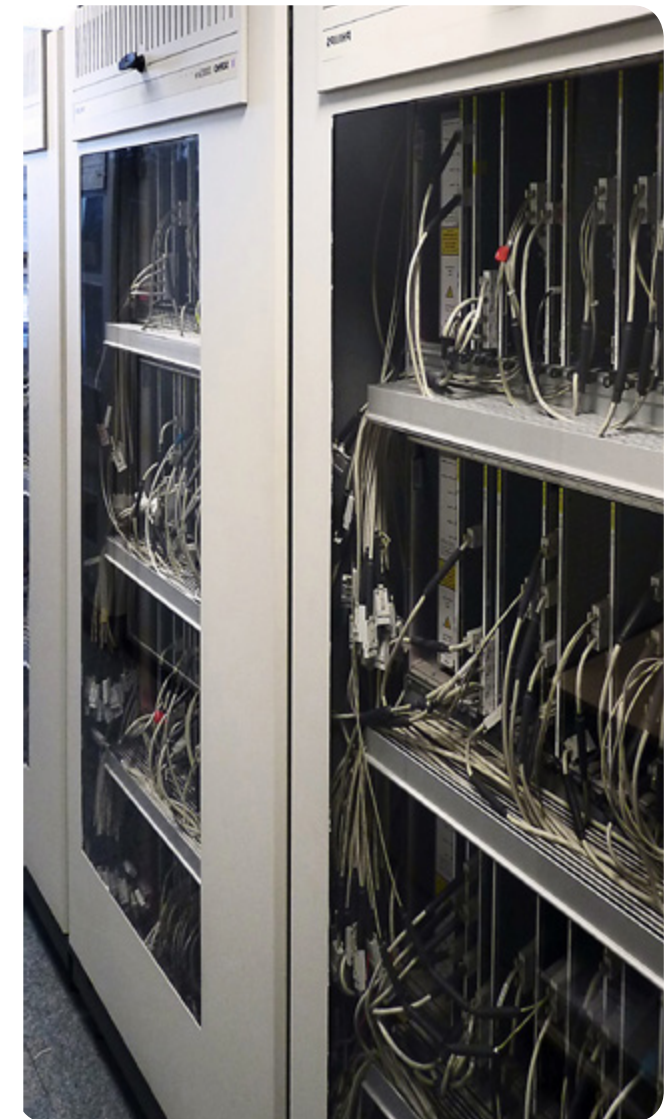
Blick in einen Verteilerschrank für Telekommunikation.
