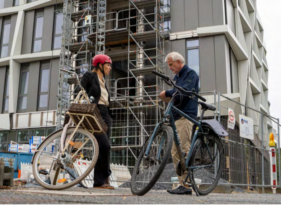
Baustellen gibt es an der Universität reichlich – die Arbeiten am „Centre for Mathematics Münster“ sind bereits weit vorangeschritten.
