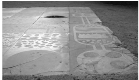
Verwitterte Bodenplatten
