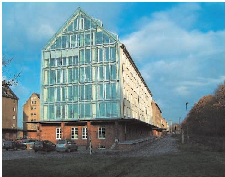
(Speicher 13) bei konstant 17°C und einer Luftfeuchtigkeit von 55%. Klimasensoren steuern die Anpassung von Temperatur und Feuchtigkeit automatisch.
