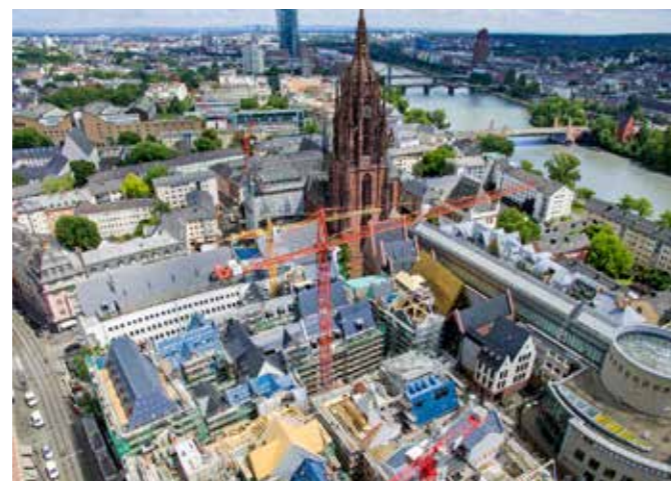
Bauarbeiten in der „Neuen Altstadt“, 2016 (Slg. Freudenberg)
