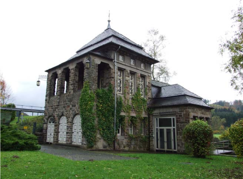
Bamenohl Finentrop Laufkraftwasserwerk
