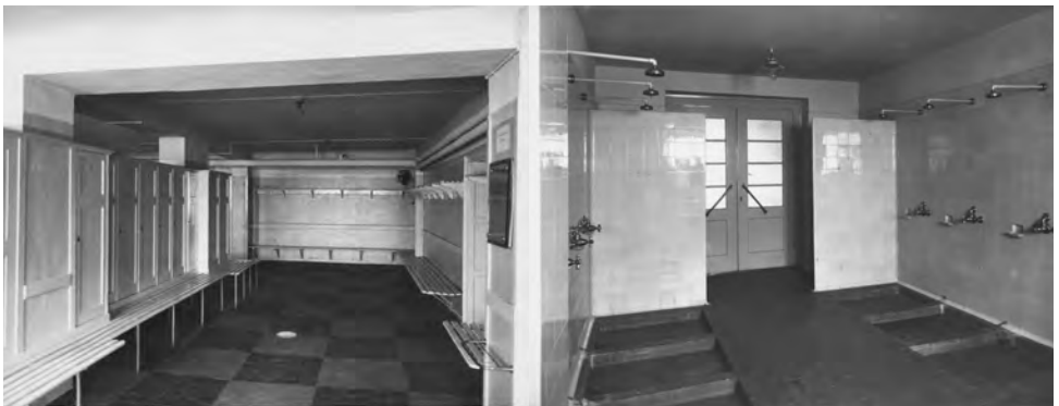
„Auskleideraum“ im Sportheim, 1927, Foto: F. Gerlach
