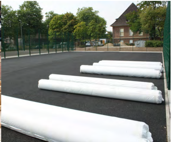
Cage-Soccer: Kunstrasen wird auf eine Asphaltsschicht gelegt, 29.8.23 Foto: S. Götschenberg
