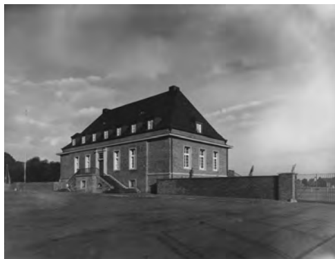
Sportheim, 1927, Ansicht von der Straße, Foto F. Gerlach
