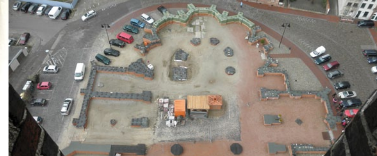
Aufgemauerter Grundriss des zu DDR-Zeiten gesprengten Kirchenschiffs der Marienkirche in Wismar
