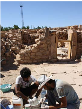
Konservierungsarbeiten im Bereich des Klosters
