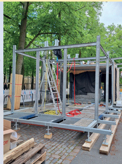
kreisl Kiste im Bau Mai 2026
