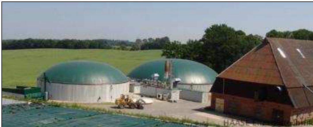
Abbildung 6: Landwirtschaftliche Biogasanlage als Nassfermentation Quelle: HAASE Energietechnik Gruppe
