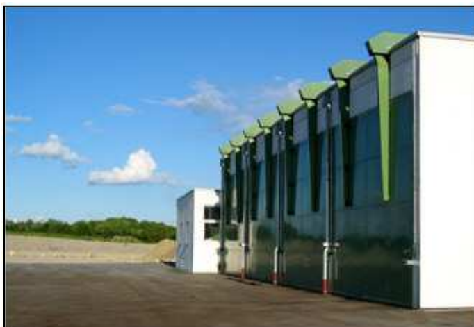
Abbildung 9: Trockenfermenter in Containerbauweise
