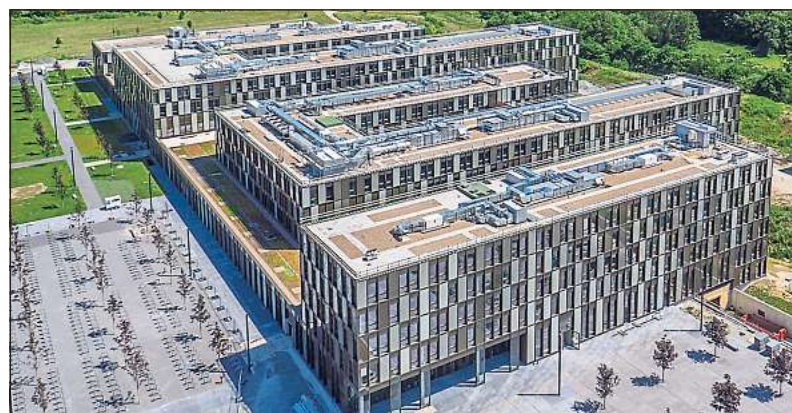
Bei der ersten Kalkulation für den Neubau der Fachhochschule Bielefeld ging der Bau- und Liegenschaftsbetrieb (BLB) NRW von Kosten in Höhe von 160 Millionen Euro aus. Tatsächlich wird das Projekt wohl rund 100 Millionen Euro teurer. Bild: BLB/Peter Smiatek
