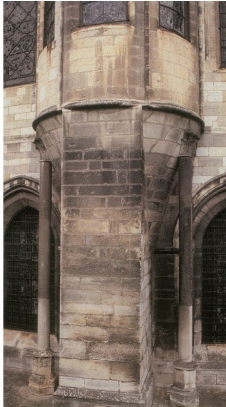
Abb. 6: Unterkonstruktion der Radialkapellen an der Krypta-Außenwand.
