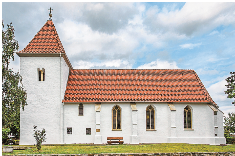
Die Dorfkirche in Holtrup bei Porta Westfalica. Der Turm ist im Mittelalter errichtet worden, das Hauptschiff im Reformationsjahr 1517.
