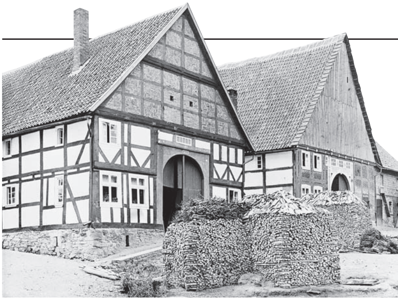
Fachwerkhäuser in Bredenborn, heute ein Ortsteil von Marienmünster im Kreis Höxter – um die Nutzung des Holzes kam es in früheren Jahrhunderten wiederholt zu Auseinandersetzungen. Foto: LWL-Landesmedienzentrum
