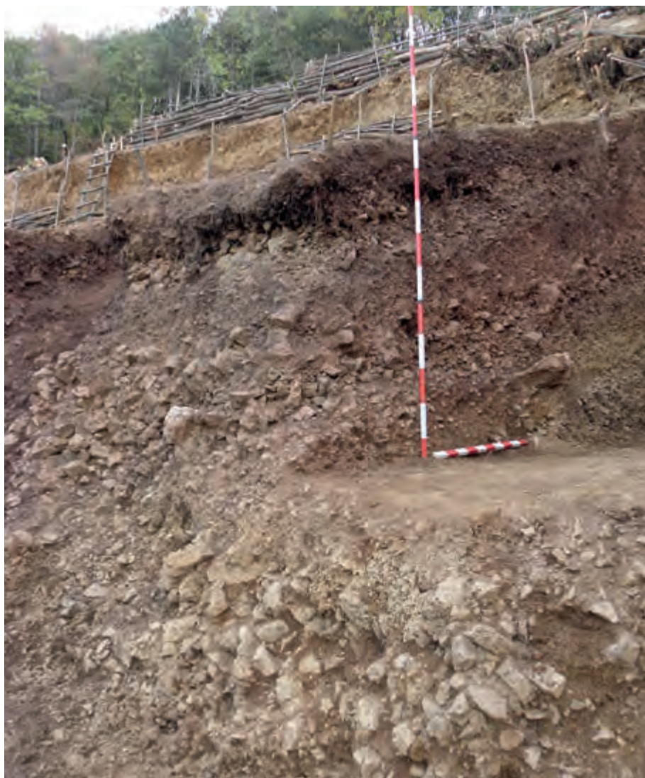
Обр. 5. Проучване на отвал на източния склон на Ада тепе
