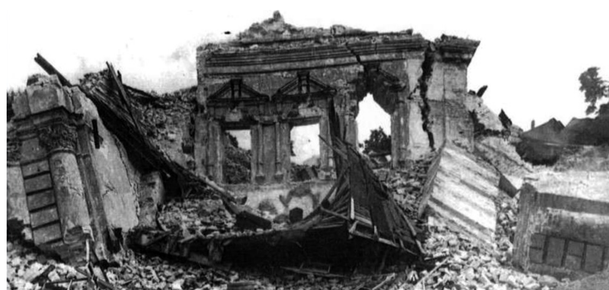
Blick auf zerstörte Klostergebäude, Aufnahme von 1937
