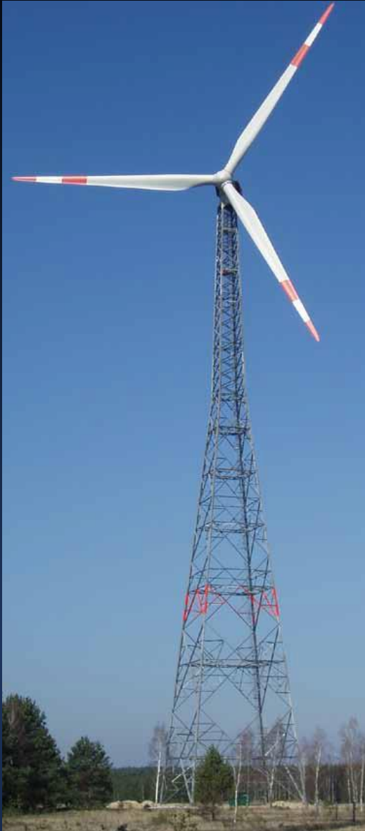
© ArcelorMittal Laasow, Brandenburg 180 m Nabenhöhe
