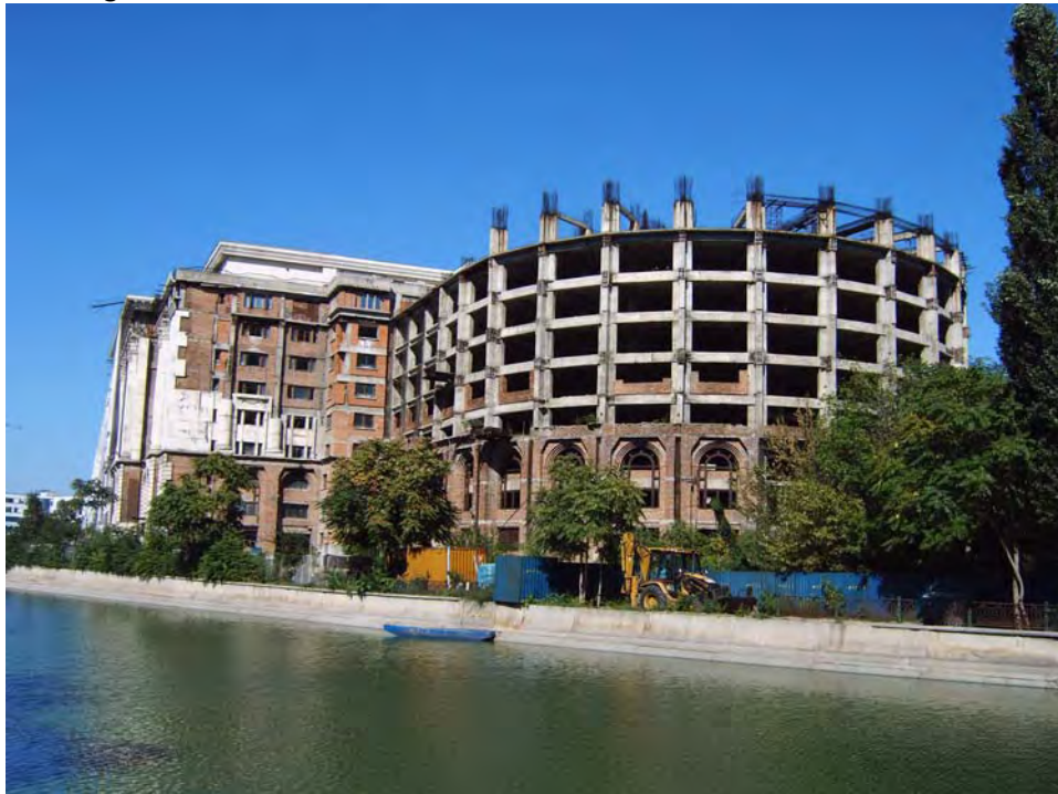
Abb. 3: Die unvollendete Nationalbibliothek im östlichen Teil der neuen Innenstadtbebauung
