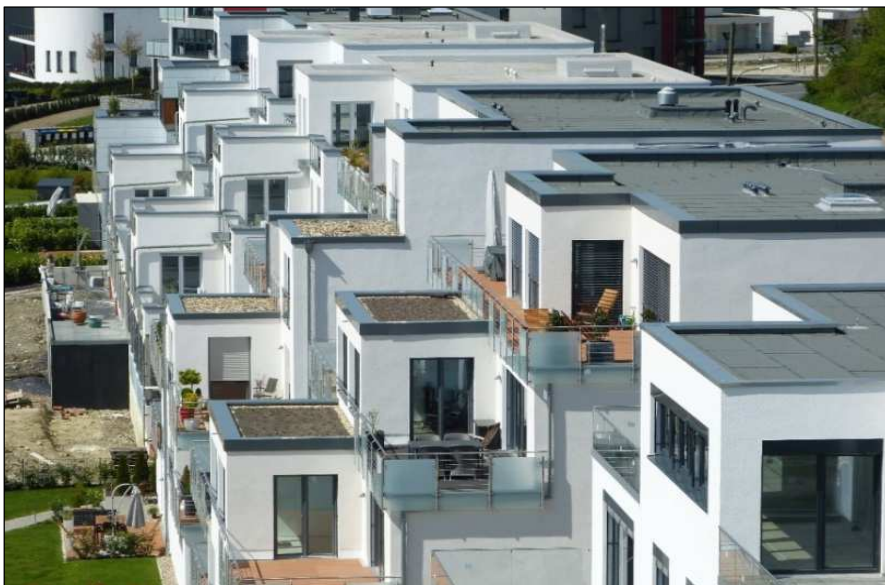
Abbildung 12: Bauweise am nördlichen Ufer des PHOENIX Sees, `Seeweg`, Blick vom Aussichtshügel
