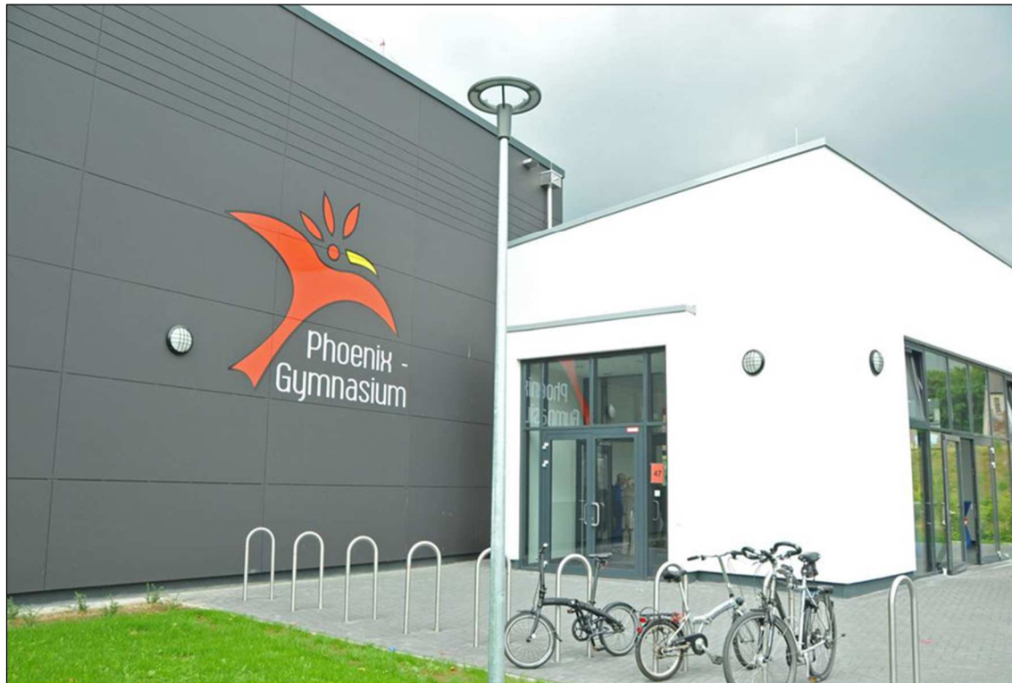
Abbildung 15: Neue Turnhalle des PHOENIX-Gymnasiums
