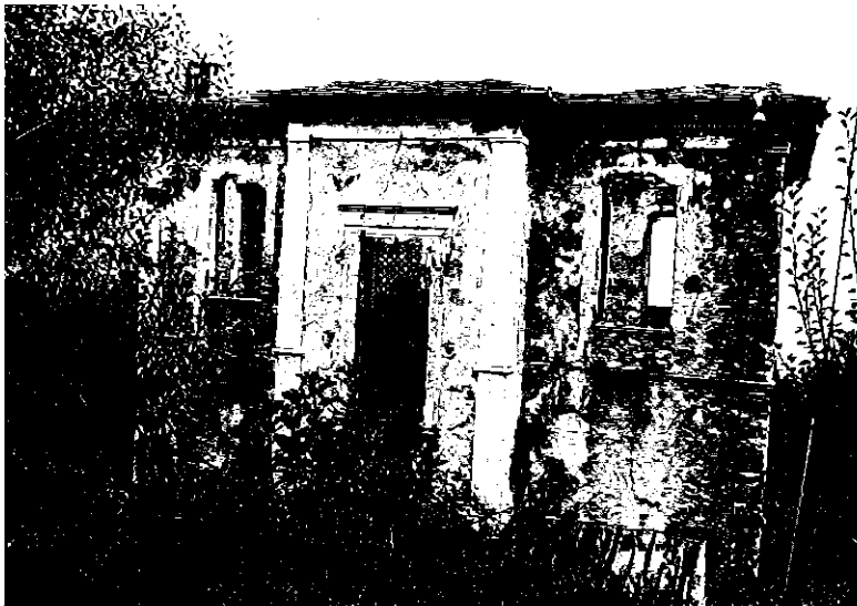
Photo 8. Ruinen eines Hauses in Muresion (August 1980)
