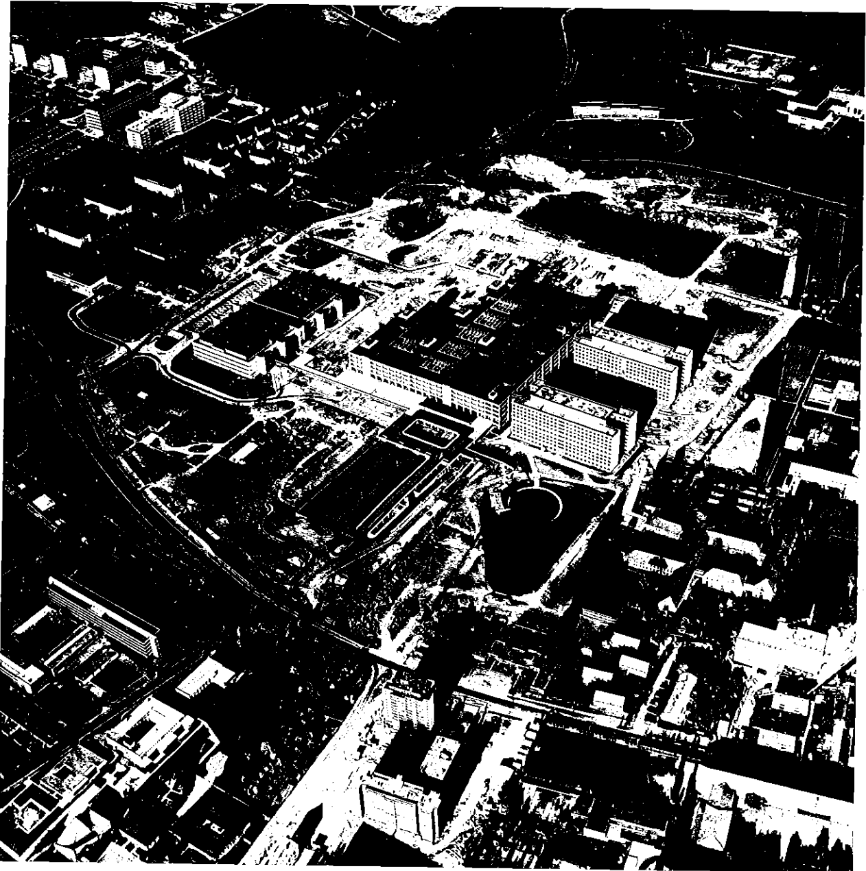
Bild 6 Neues Klinikum der Universität Göttingen mit Blick nach Osten (Mai 1974)
