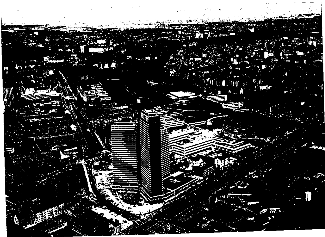
Bild 1 Uni-Center-Hochhaus und Gebäude der Universität Köln mit Blick nach Norden (1974)
