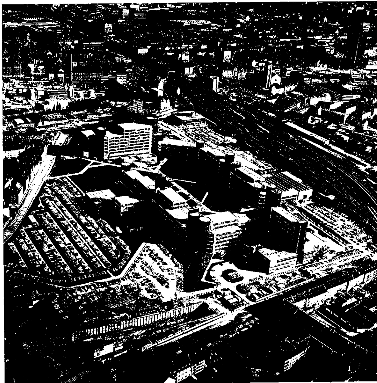
Bild 23 Universität Essen und nördliche Essener City (Blick nach Osten) (August 1978)
