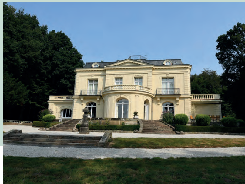
› Landhaus Rothenberge, Gartenseite / garden façade, 2018
