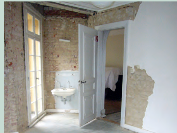
› Mitte / in the middle: Einbau des neuen Fluchttreppenhauses / The installation of a new escape staircase › Rechts / on the right: Ein Innenraum während der Renovierung / A room during renovation
