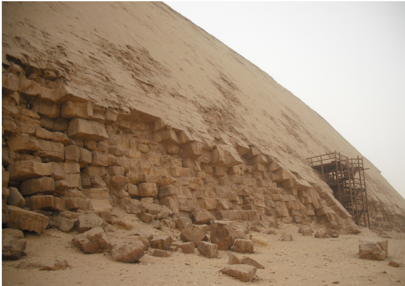
Abb. 7.: Die Außenverkleidung der Knickpyramide ist weitgehend erhalten geblieben.
