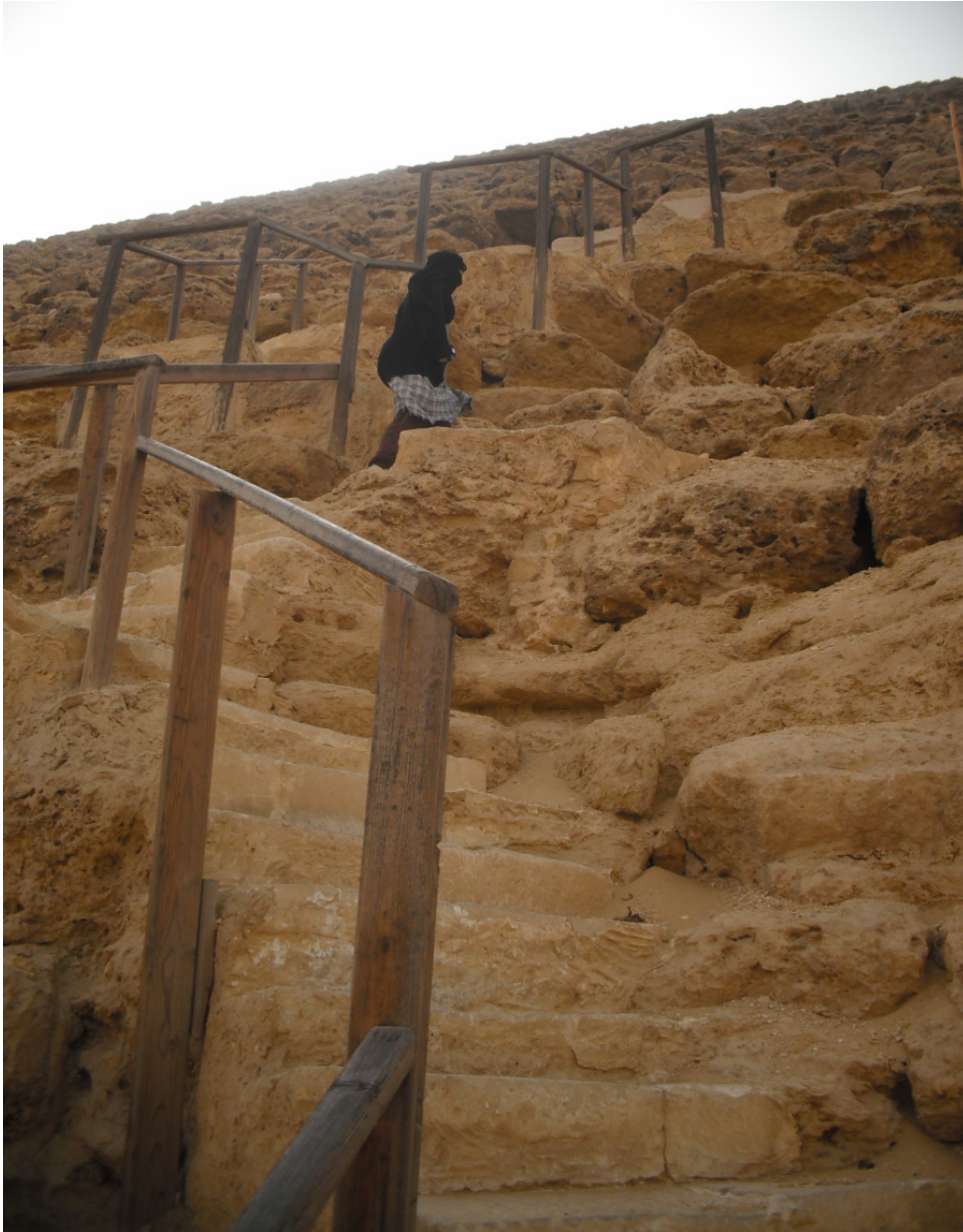
Abb. 8.: Treppe zum Einstieg in die Rote Pyramide
