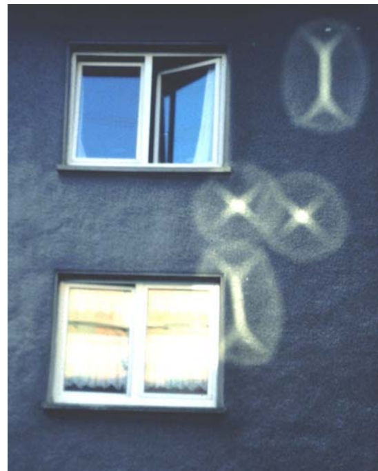
Bild 11: Typischer Reflex einer bestrahlten Doppelscheibe.
