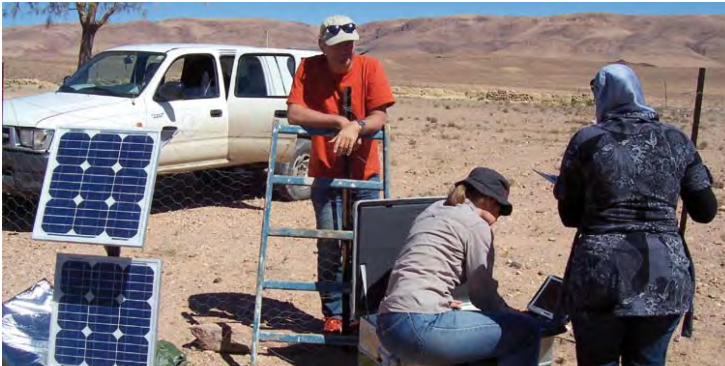
Aufbau einer seismischen Station in Marokko (im hohen Atlas) als Teil des Münster-Marokkoarrays. Der Sensor, Datenlogger, die GPS Antenne sowie die Solarzellen müssen installiert werden.
