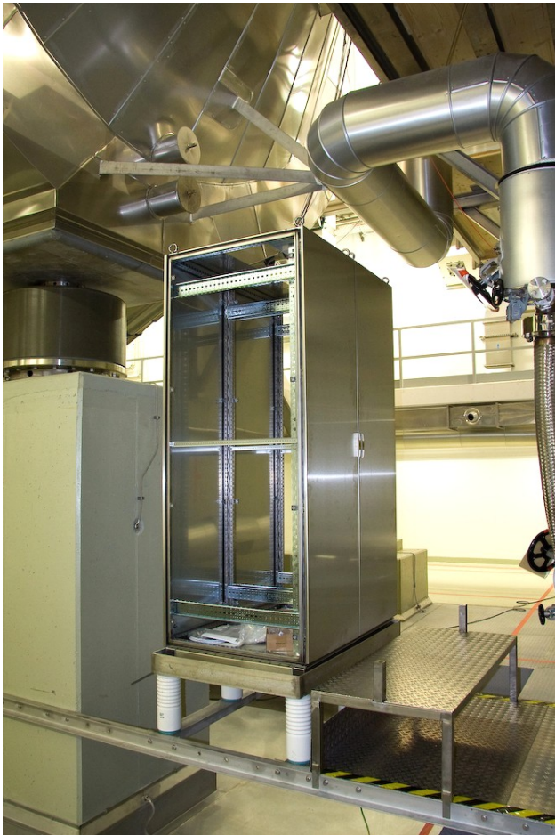
Abbildung 5.2.: Aufbau der Hochspannungsschränke in der KATRIN-Halle. In dieser Abbildung sind die beiden Schrankhälften gezeigt wie sie auf den Isolatoren in der KATRIN-Halle unterhalb des Hauptspektrometers aufgestellt sind.
