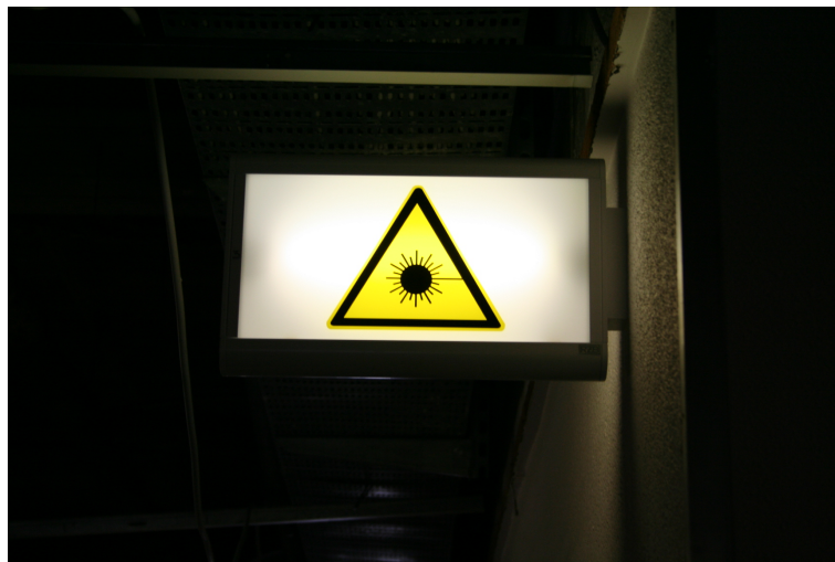
Abbildung 3.1: Bild der Warnleuchte: Ist die Leuchte an, so signalisiert sie den anderen Personen, dass der Laser in Betrieb ist. Sie dürfen das Labor aber betreten. Ist zusätzlich ein „Zutritt verboten“ Schild über der Türklinke, so ist dies nicht mehr gestattet.
