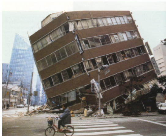
Abbildung 1: Eingestürztes Haus nach dem Erdbeben in Kobe
