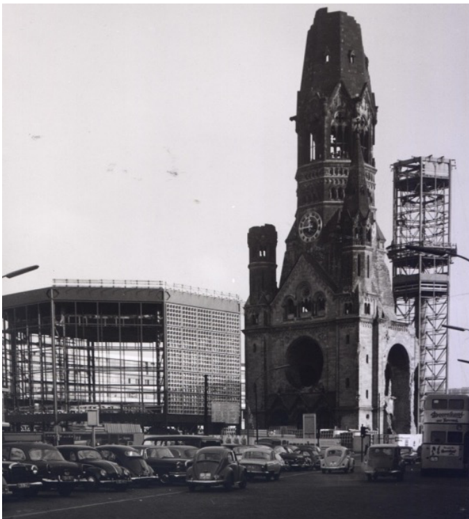
Abb. 8: Egon Eiermann, Kaiser-Wilhelm-Gedächtnis-Kirche in Berlin, 1959–1961, Rohbau mit Betonwaben, in: Liptau/Erne (Hg.), Licht – Material und Idee im Kirchenbau der Moderne . Kromsdorf/Weimar: Jonas Verlag 2017, 58.
