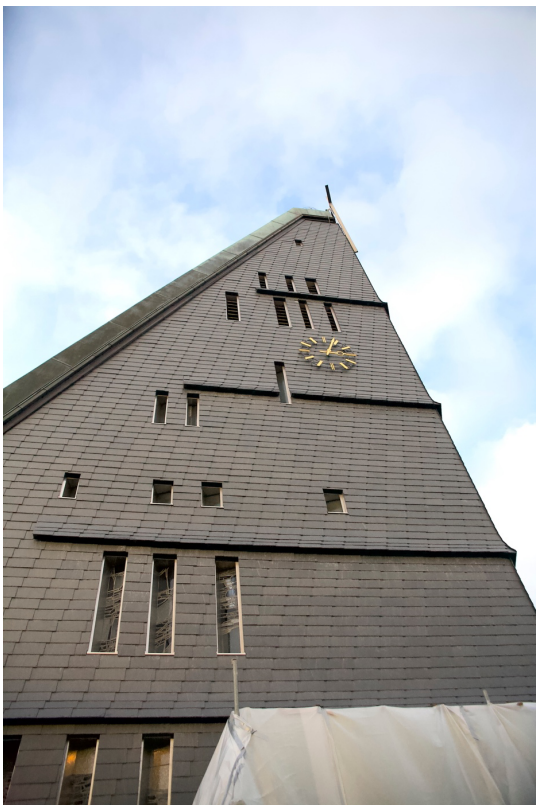
Abb. 6b: Berthold Himmelmann, Ev. Kirche in Sarnau, 1966–1968, Renovierung 2014, Foto: Ev.-luth. Kirchengemeinde Goßfelden und Sarnau.
