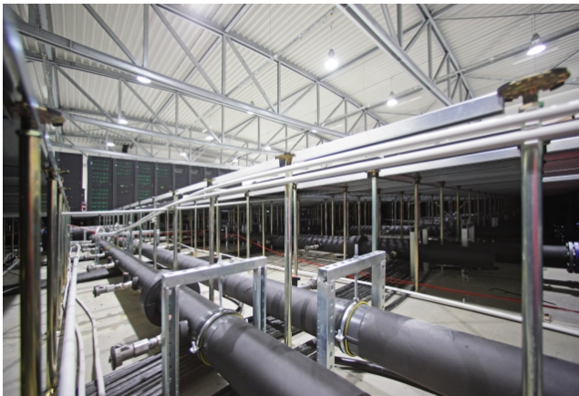
Kühlwasserleitungen im Boden
