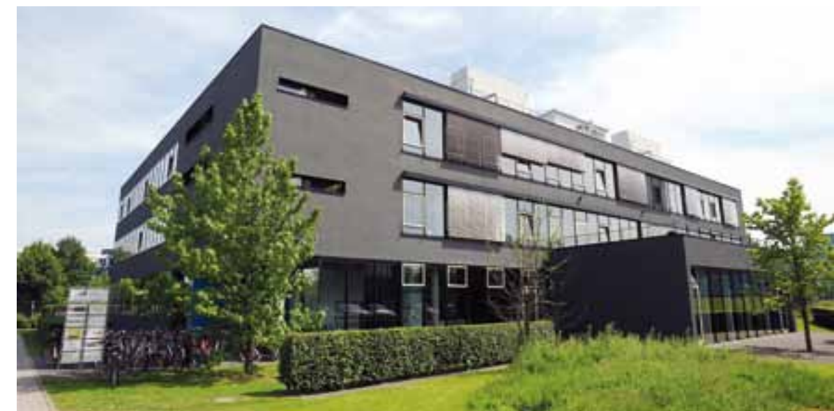
Gebäude des Centrums für Nanotechnologie | Home of the Centre for Nanotechnology (CeNTech) in Münster
