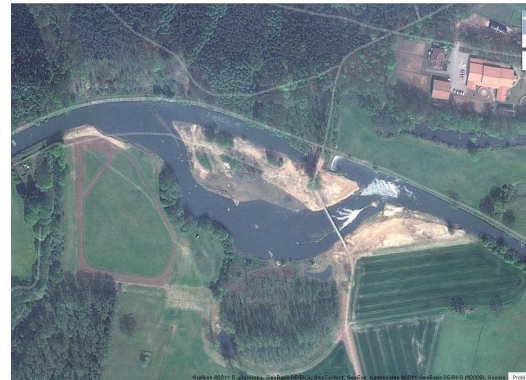
Emsverlauf nach Anlegung des Initialgerinnes
