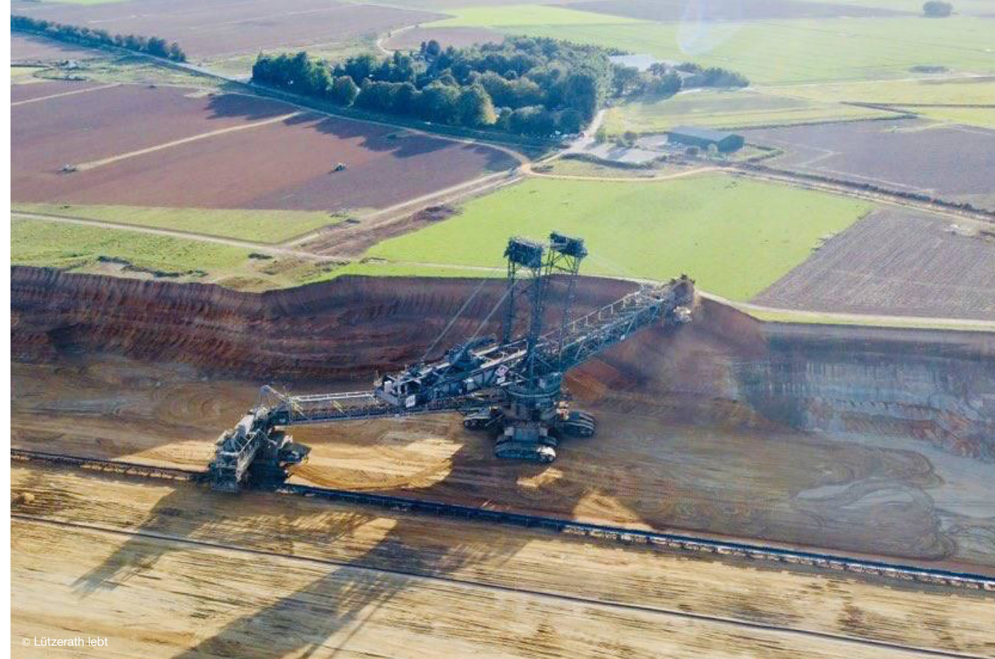
Der Kohlebagger stand im Herbst 2022 schon kurz vor den Toren Lützeraths
