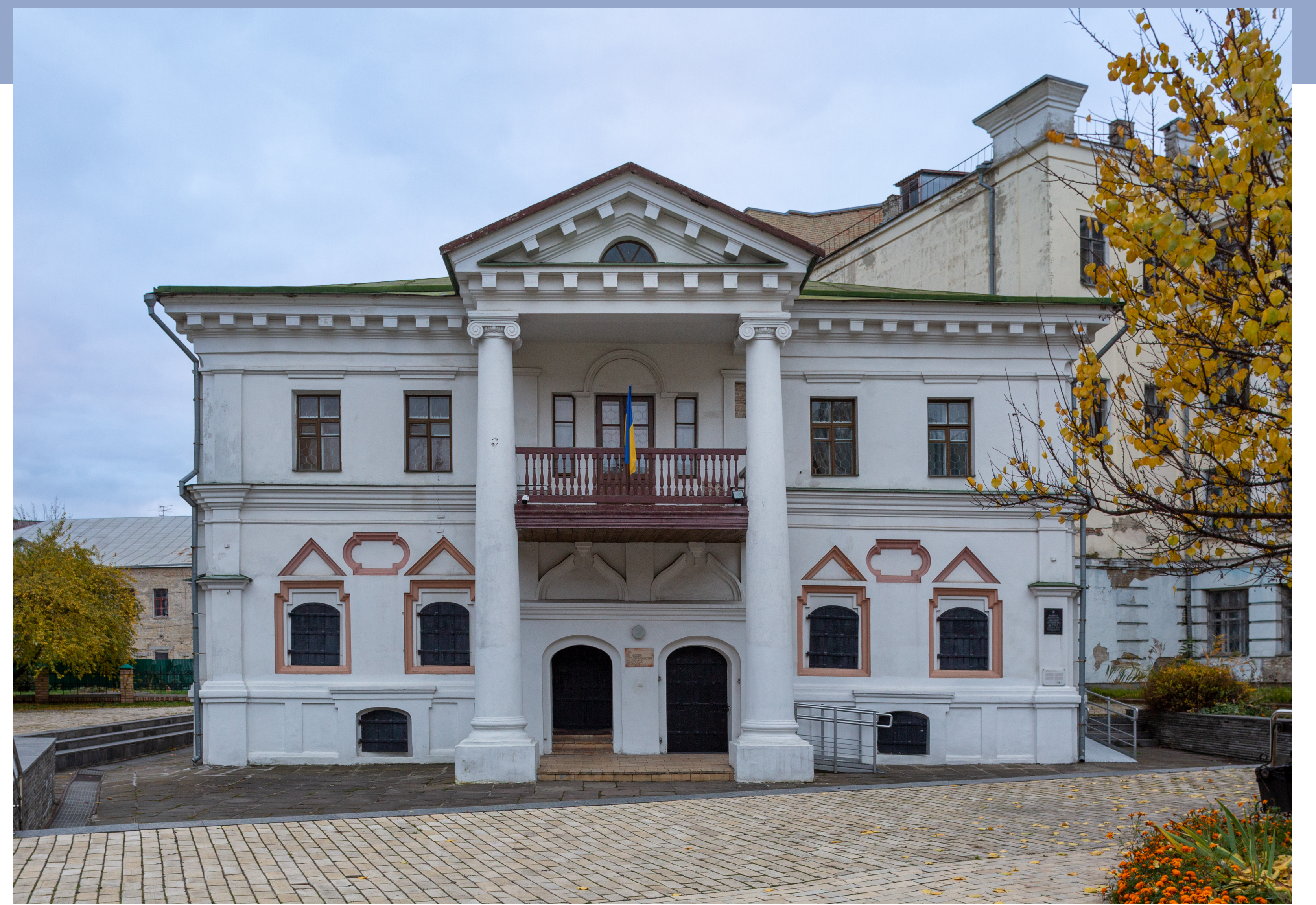
Kiew, Masepa-Haus (heute: Hetman-Museum), Gesamtansicht von Norden @ Bildarchiv Foto Marburg / Mykhailo Chorniy (2022)
