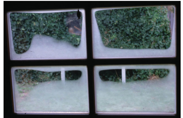
Abb. 2 Kondensierter Wasserdampf an Fensterscheiben.
