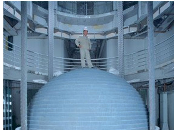
Abb. 3 Schwingungstilgerpendel im Taipei 101.
