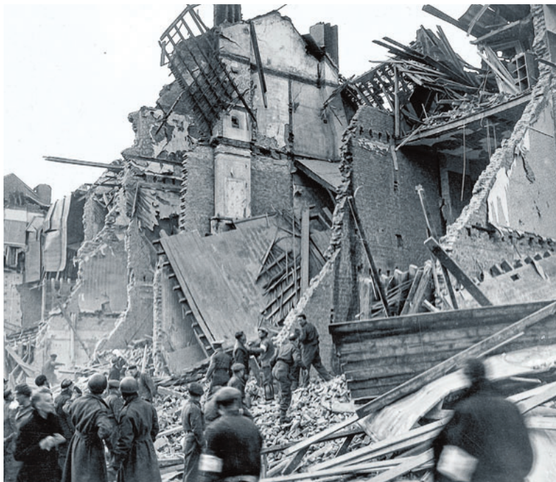
In mei 1944 verwoestte een V-bom een huizenblok in de Durlletstraat.
