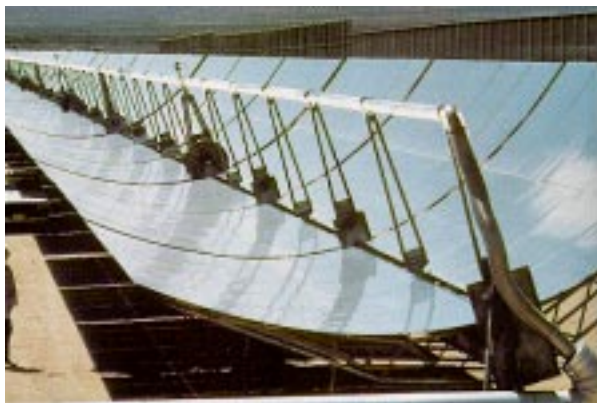
Abbildung E1: Parabolförmiger Rinnenkollektor eines 80 MW Dampfkraftwerks in Kalifornien. Quelle: Pilkington Solar International
